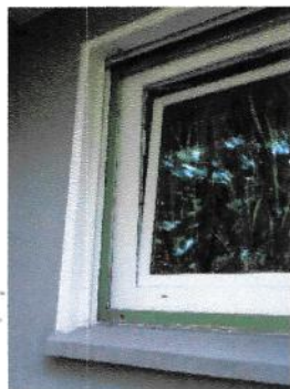
Erhaltene Metallrahmen, dahinter später eingebaute Kunststofffenster (grüne Fassung eventuell bauzeitlich)
