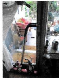
Erhaltene Ladentür in einer der Wohnungen
