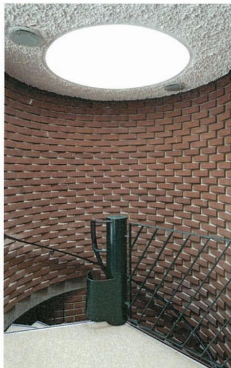
Wendeltreppe von der Bar hinunter zur Kegelbahn mit schuppenartig gelegten Backsteinläufern, grober Spritzputz und Okulus, bauzeitliches Geländer (SW)
