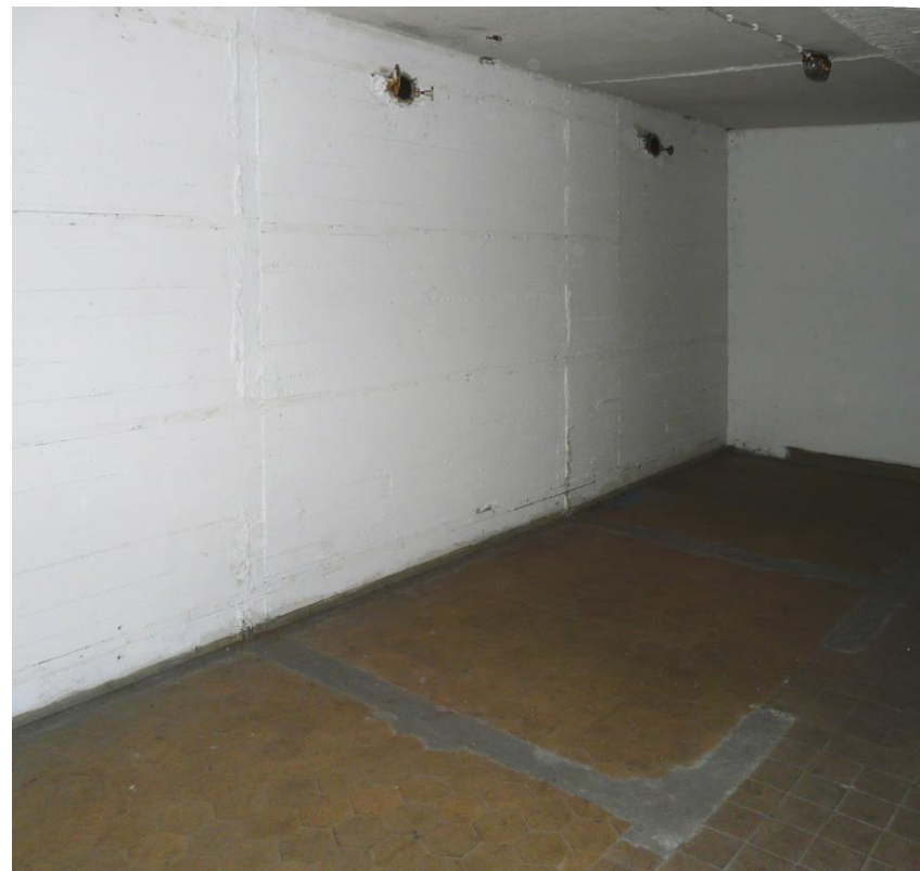
Raum mit Spuren der Anordnung ehemaliger Teilungswände (Spuren auf dem Fußboden, an der unverputzten Betonwand und an der Decke.) Oben an der Wand zwei nach außen führende Entlüftungsöffnungen mit erhaltenen Verschlüssen. Bodenfliesen.
