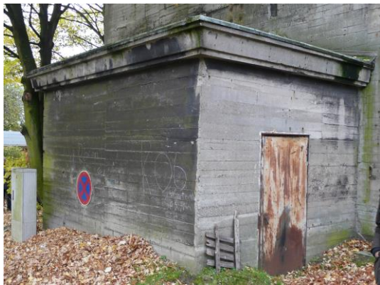
Eingangsvorbau an der Nordseite.
