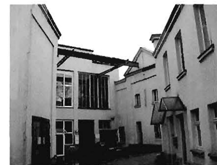
Teil der Kraftzentrale Ansicht vom Hof
