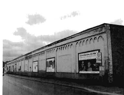
Außenwand der Produktionshalle
