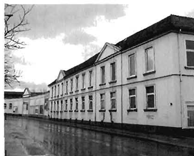
Verwaltungsgebäude an der Ringstraße
